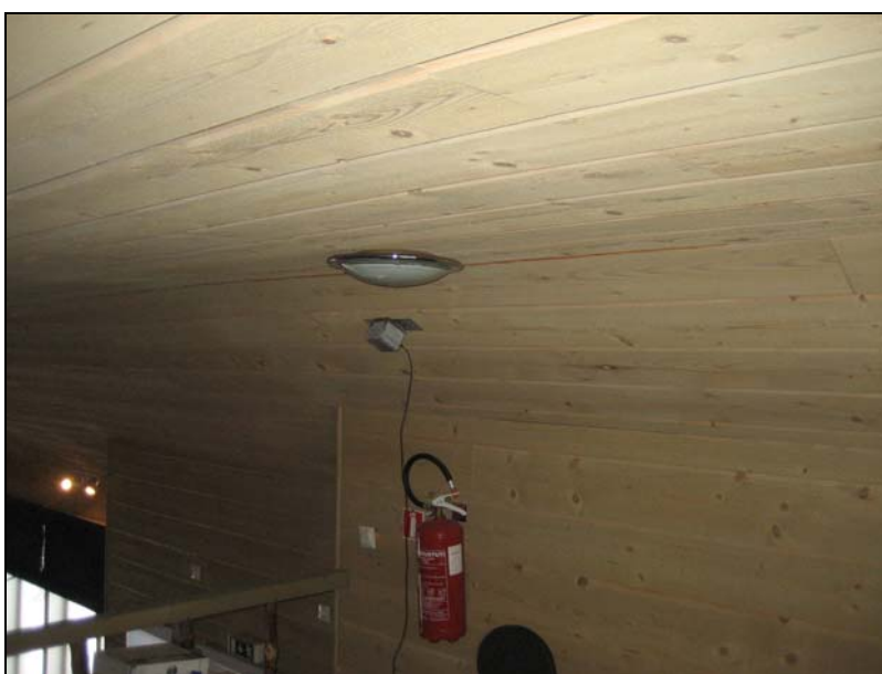
Foto 6. Mõõtmispunkt P1 (hoone katuslae külge kinnitatud vibratsiooniandur)
